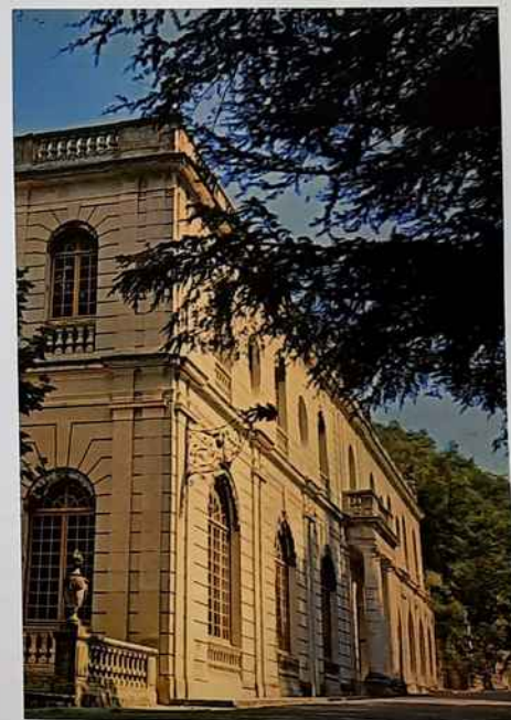
Forêt de Saoû, Auberge des Dauphins. L'hôtel des Dauphins, réplique du Petit Trianon de Versailles, édifié en 1928-1929 par Maurice Burrus, industriel et député du Haut-Rhin ; la façade principale de style classique vue du Sud-Ouest (Architecte Paul Boyer). Date : 1960 - 1970.
